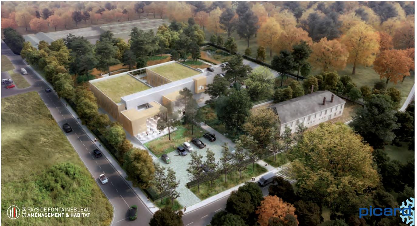
Vue aérienne du nouveau siège social de PICARD
