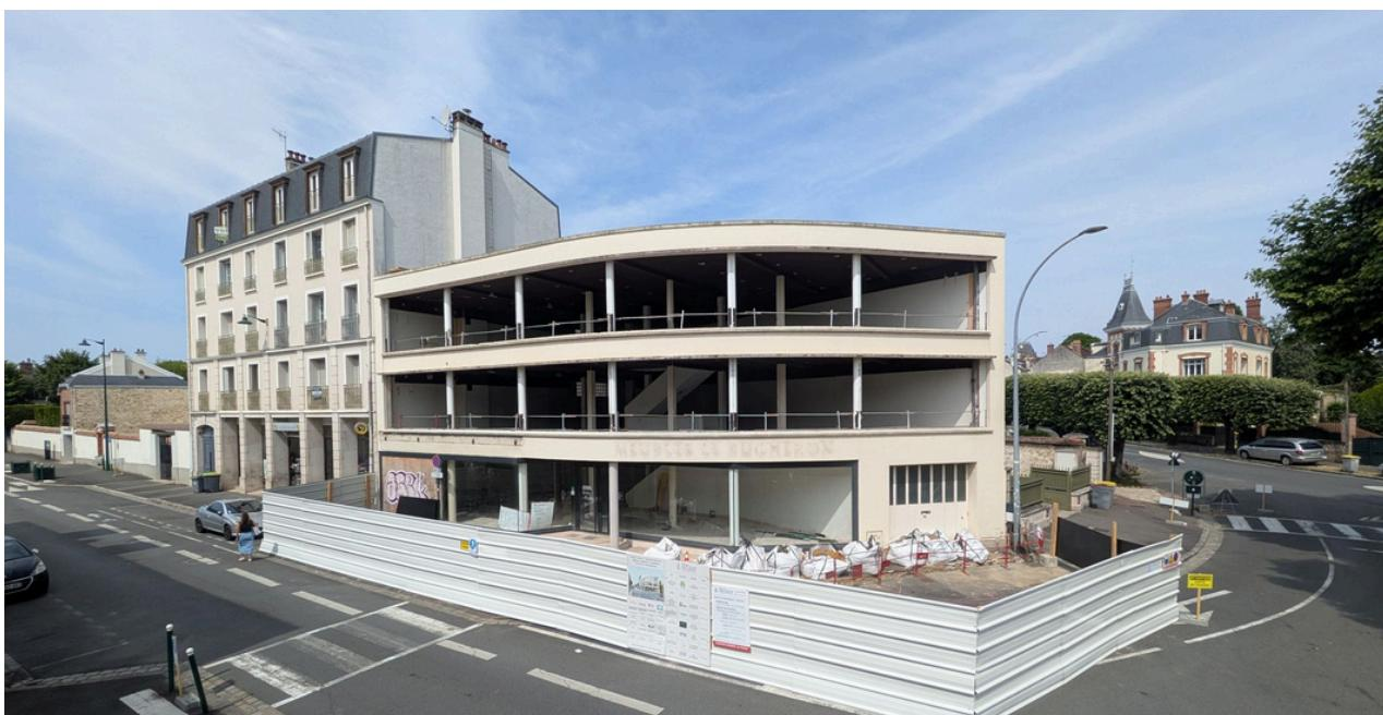
Confié au cabinet d’architecture Lemoal, cette réhabilitation prévoit une restructuration du bâti, en incluant l’installation d’un ascenseur, la création de nouveaux accès, le remplacement des fenêtres et vitrine de façade, ainsi qu’une mise aux normes environnementales.
